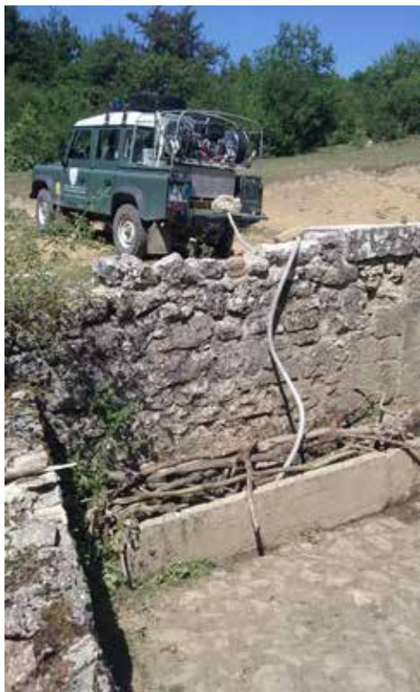
Intervento di mantenimento del livello idrico in un abbeveratoio presso Barrea (Valentina Rovelli)
